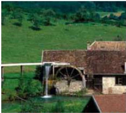
Roue d'entraînement des soufflets de forge, atelier du petit martinet
