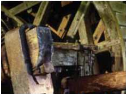
Ordon de martinets de forge et roue hydraulique à augets
